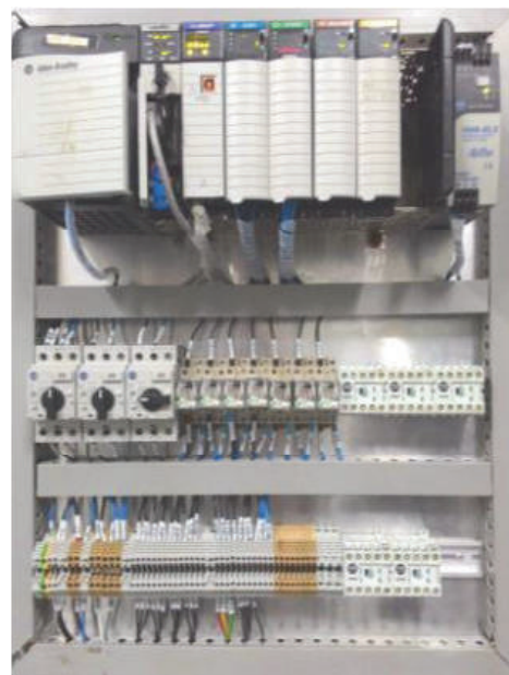
Gambar 9. Rangkaian Kendali PLC
