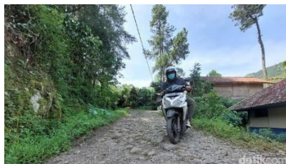
Gambar 1.1 Kondisi jalan rusak di pelosok pada 2020
