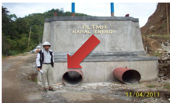
Gambar 13 : Keluaran Penstock dari Kolam Penenang
