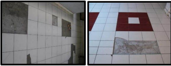
Gambar 5 Keramik yang Lepas Blok A & Blok B (Data Penelitian, 2016)
