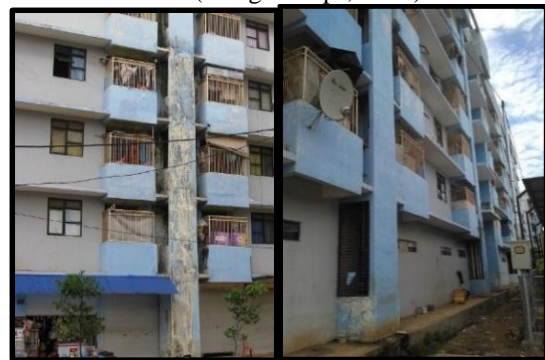
Gambar 2 Cat Dinding yang Mengelupas & Memudar Blok A & Blok B (Data Penelitian, 2016)
