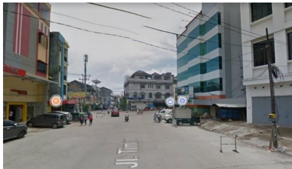
Gambar 3. Kondisi Ruas Jalan KH Ramli
