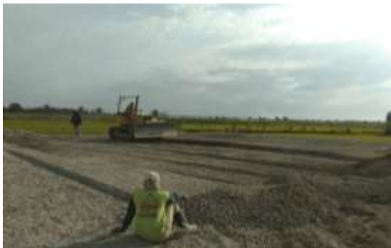
Gambar 9. Pekerjaan Base Course
