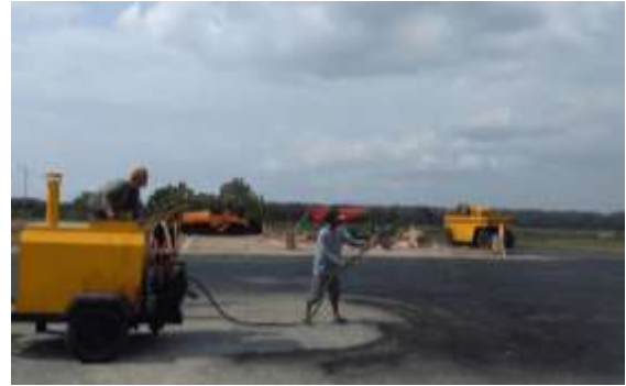
Gambar 10. Pekerjaan Prime Coat
