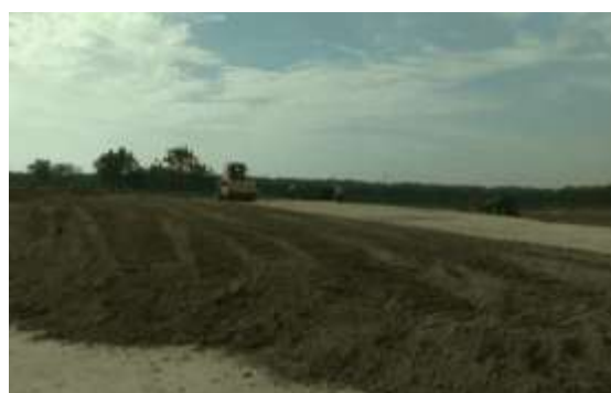
Gambar 7. Pekerjaan Pemadatan Subgrade
