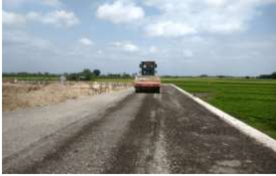
Gambar 8. Perkerjaan Subbase Course
