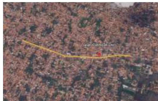
Gambar 1. Ruas Jalan Cut Nyak Dien
