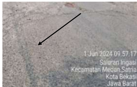
Gambar 4. Pelapukan dan Butiran Lepas ( Raveling )
