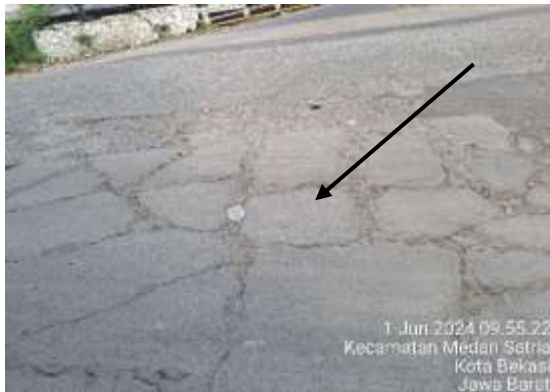
Gambar 5. Retak Kotak
