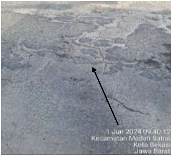
Gambar 2. Pengelupasan ( Stripping )
