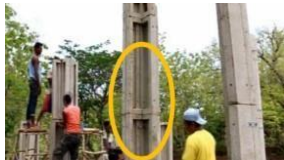
Gambar 4. Panel Struktural P2 sebagai Kolom
