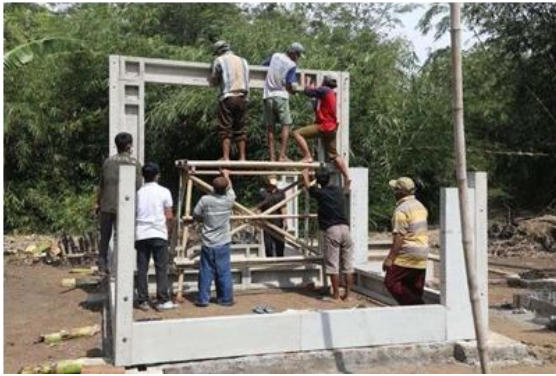
Gambar 12. Proses Pemasangan Komponen Rumah RUSPIN
