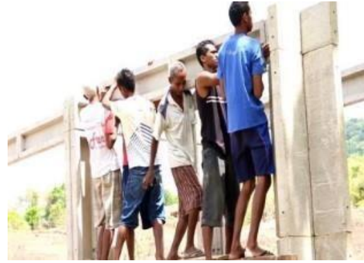
Gambar 2. Panel Struktural P1 sebagai Balok
