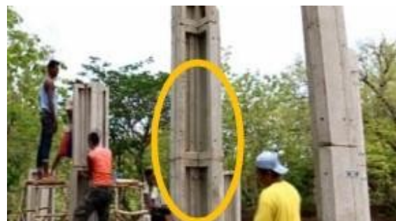
Gambar 4. Panel Struktural P2 sebagai Kolom
