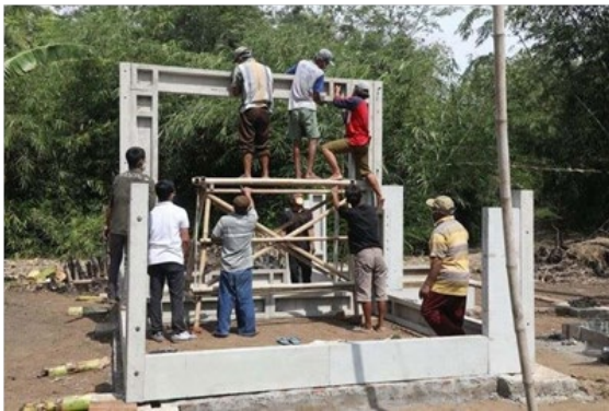
Gambar 12. Proses Pemasangan Komponen Rumah RUSPIN
