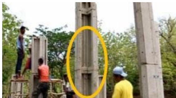
Gambar 4. Panel Struktural P2 sebagai Kolom
