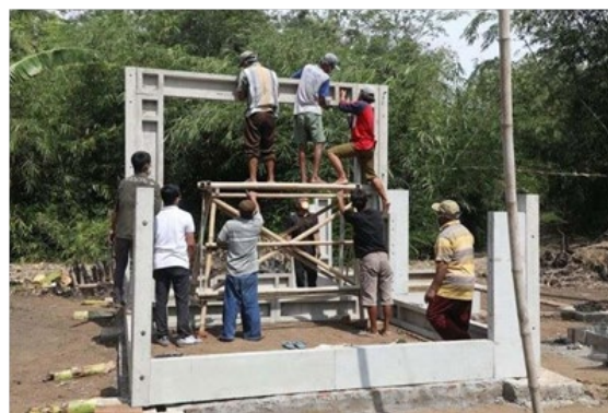
Gambar 12. Proses Pemasangan Komponen Rumah RUSPIN
