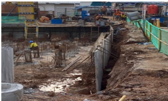
Gambar 7. Pemasangan Bekisting Precast
