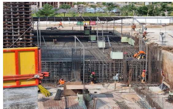
Gambar 8. Pemasangan Tulangan Pondasi
