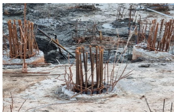
Gambar 4. Pembobokan Tiang Sesuai Cut Off Level
