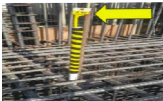
Gambar 9. Pemasangan Thermocouple
