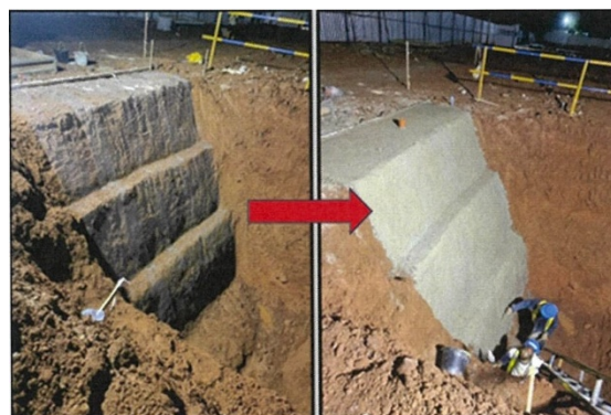
Gambar 6. Pekerjaan Proteksi Lereng
