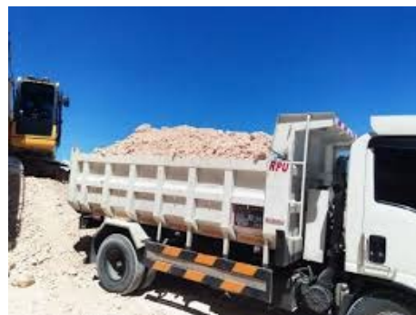
Gambar 1. Pekerjaan Urugan Lime Stone (Dokumentasi Penelitian)
