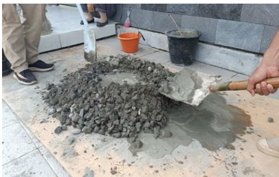
Gambar 4. Proses Pengadukan Beton
