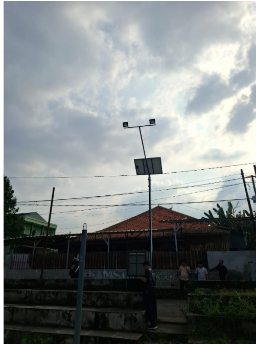
Gambar 4. Alat Penerangan Otomatis Berbasis Panel Surya yang Berhasil Dipasang di Lokasi
