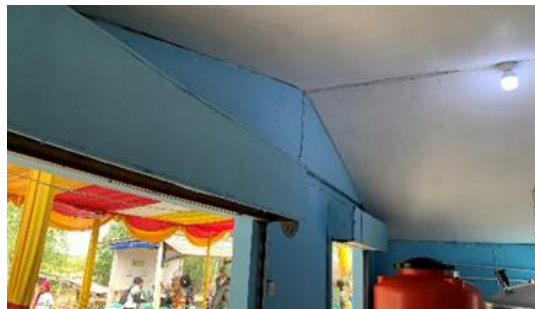
Gambar 4. Kondisi Dalam Pembangunan Setelah Revitalisasi
