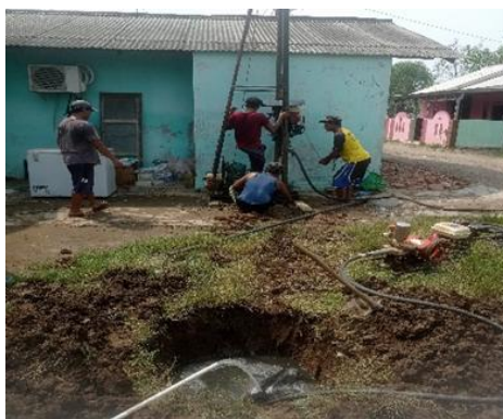
Gambar 2. Pengeboran Sumur Resapan
