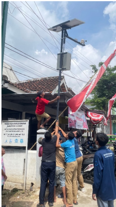
Gambar 2. Proses Pemasangan Alat EWS
