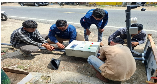
Gambar 1. Persiapan Pemasangan Alat EWS
