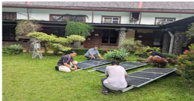
Gambar 9. Pengujian Panel Surya Sebelum Pemasangan
