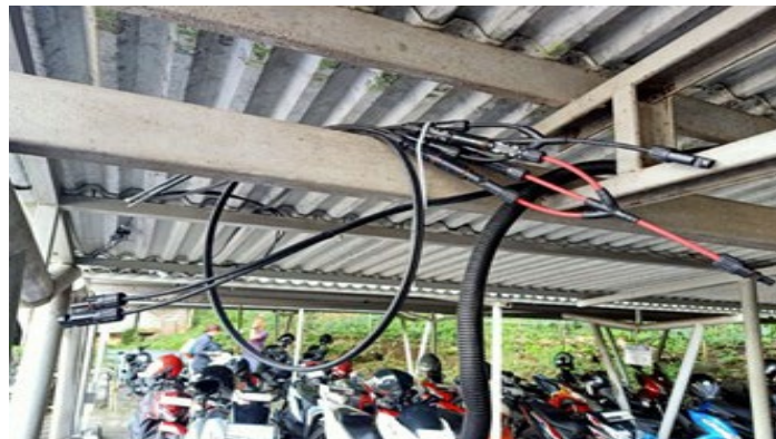
Gambar 11. Pemasangan Kabel dan Konektor MC4
