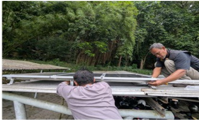
Gambar 10. Pemasangan Panel Surya di Atap Tempat Parkir Motor
