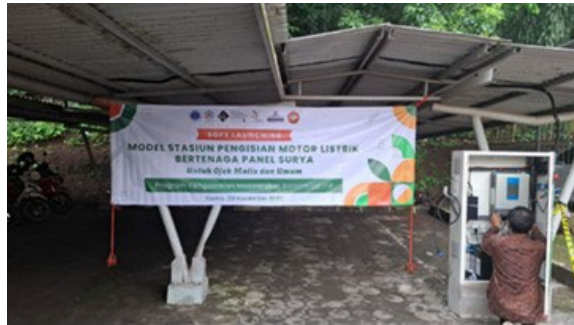
Gambar 13. Persiapan Kotak Panel Sebelum Peresmian
