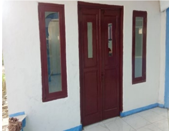
Gambar 4. Kondisi Dinding Luar Setelah Revitalisasi
