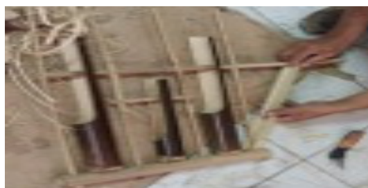
Gambar 3. Pembuatan/Pemasangan penyanggah segitiga Sumber: Dokumentasi Pribadi, 2022
