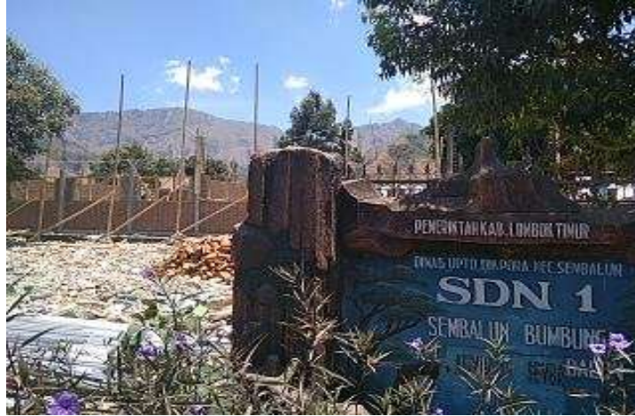
Gambar 6. Kondisi fisik SDN 1 Sembalun Bumbung, mengalami kerusakan parah.
