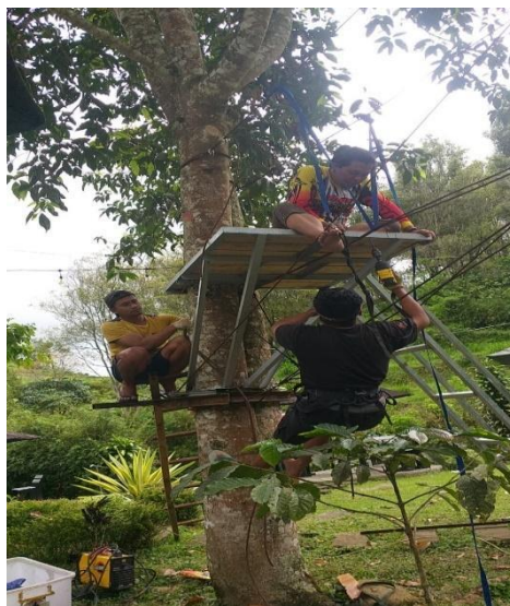
Gambar 7. Proses Pembangunan Wahana Wisata High Bridge Rope
