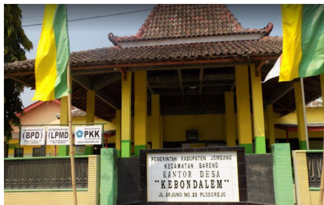
Gambar 1. Kantor Balai Desa Kebondalem
