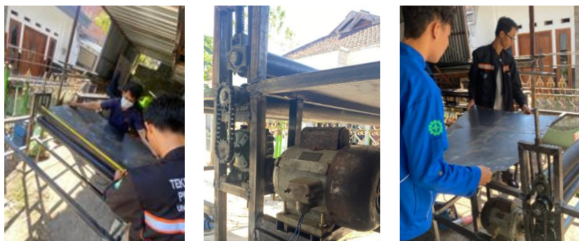
Gambar 4. Proses perakitan akhir Mesin Pelapis HPL
