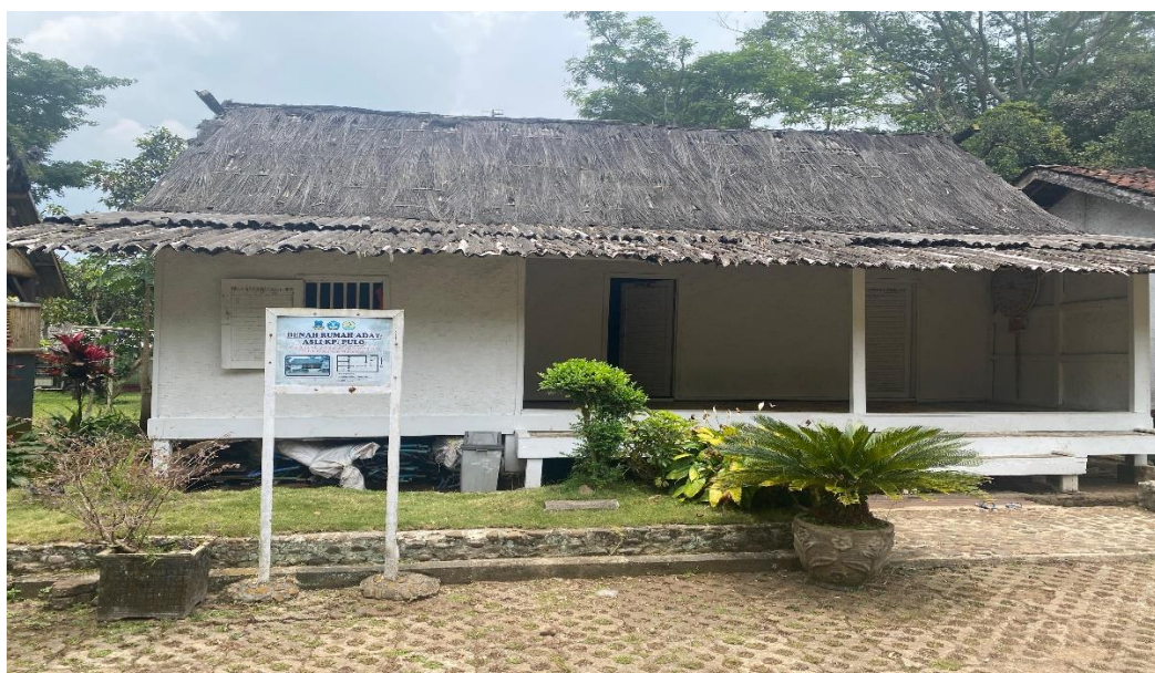
Gambar 1. Bangunan asli Kampung Adat Pulo
