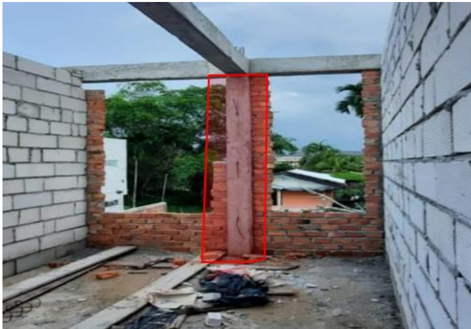
Gambar 5. Kolom Lantai 2
