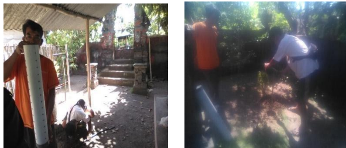
Gambar 9. Kegiatan pemasangan biopori di rumah warga
