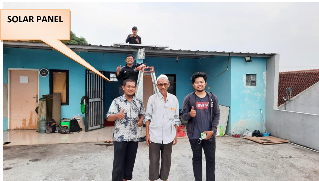
Gambar 7. Proses Pemasangan Solar Panel Di Atap Rumah Qur'an
