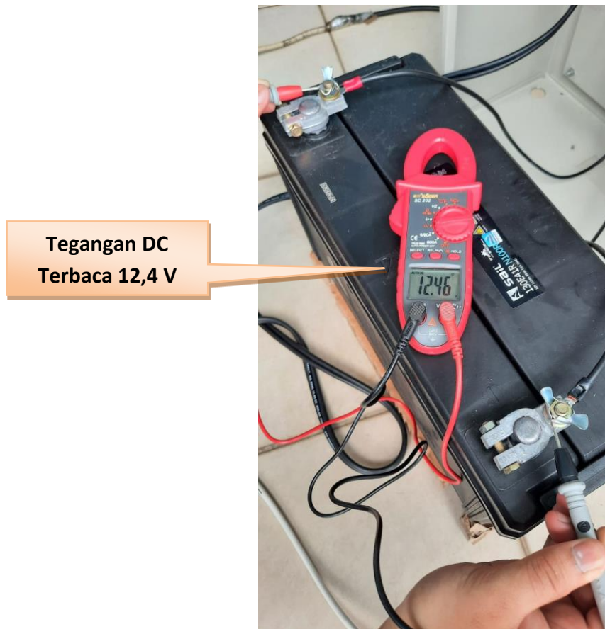
Gambar 11. Pengukuran Tegangan Listrik DC dari Battery
