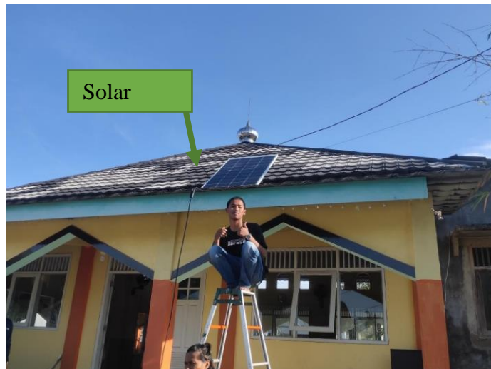
Gambar 10. Pemasangan Solar Panel Di Atap Masjid
