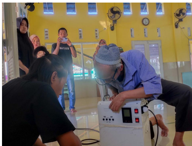
Gambar 11. Pemasangan Kabel Solar Power Generator
