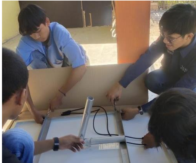
Gambar 9. Pemasangan Kabel Solar Cell
