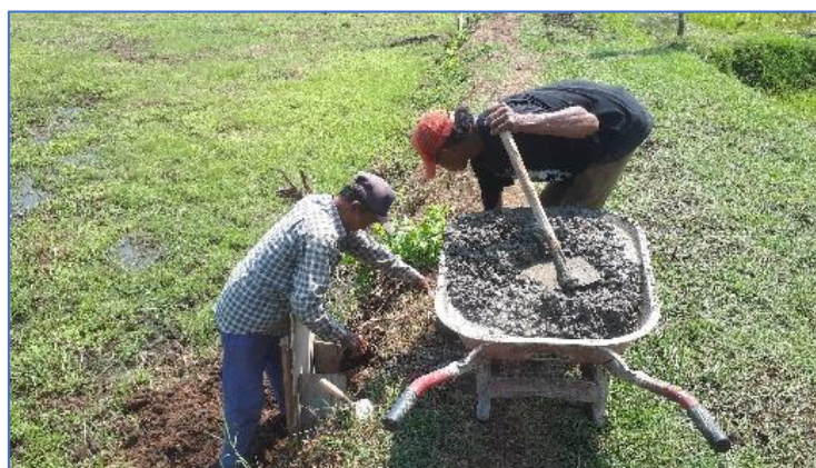
Gambar 7. Pembuatan Dudukan tiang lampu
