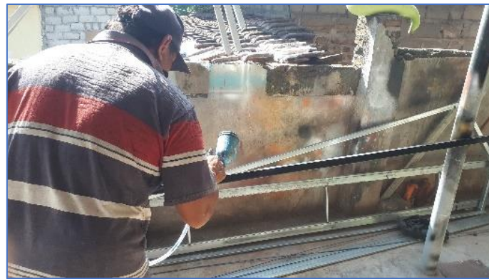
Gambar 6. Pengecatan Tiang Lampu
