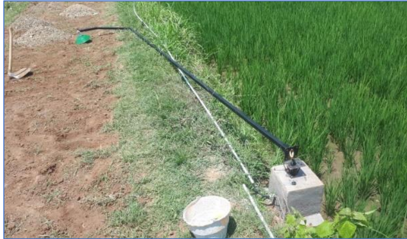
Gambar 11 Pemasangan Tiang Lampu pada dudukan tiang
