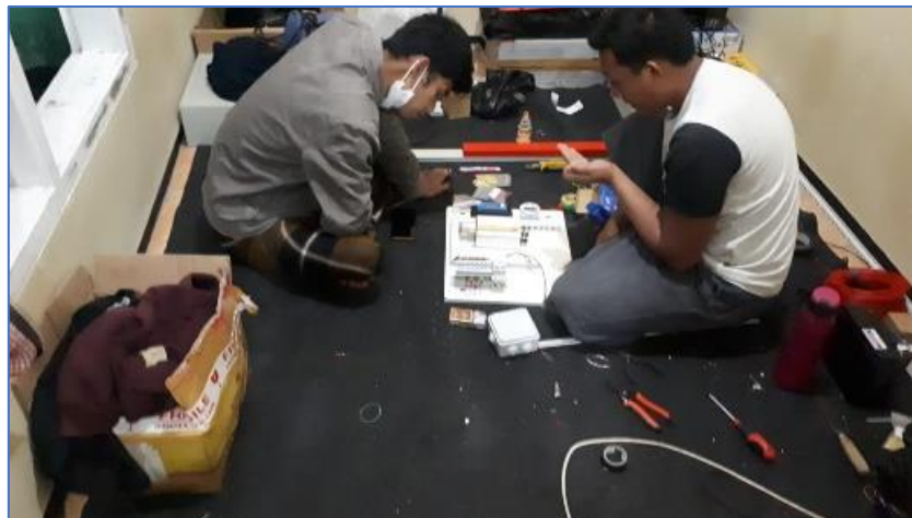
Gambar 9 Pembuatan box panel kelistrikan
