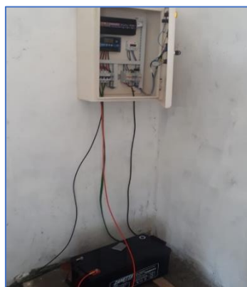
Gambar 13 Pemasangan Box Panel Kelistrikan dan Baterai
