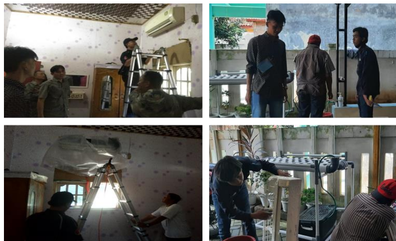
Gambar 4. Praktek perawatan membersihkan AC split.
