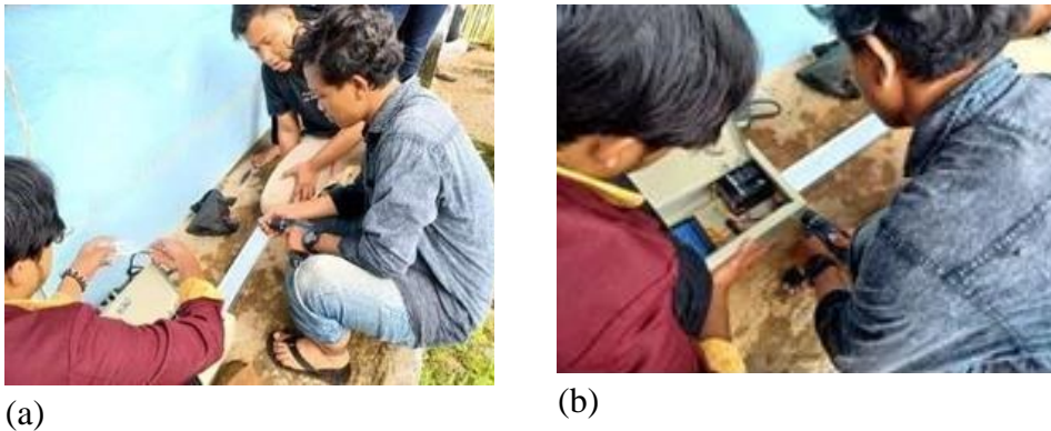
Gambar 2. (a) Pembuatan tiang, dan (b) perangkaian panel box
