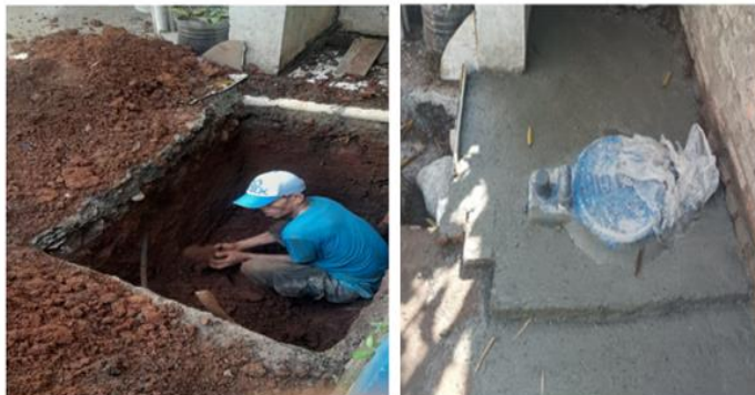
Gambar 2 Penggalian Lubang dan Pemasangan Septik Tank Biotech
