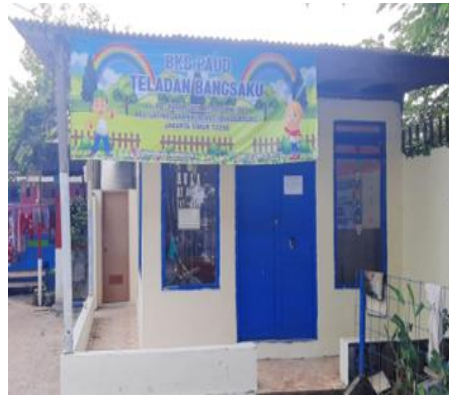
Gambar 4. Pengecatan Dinding dan Perapihan Hasil Renovasi PAUD
