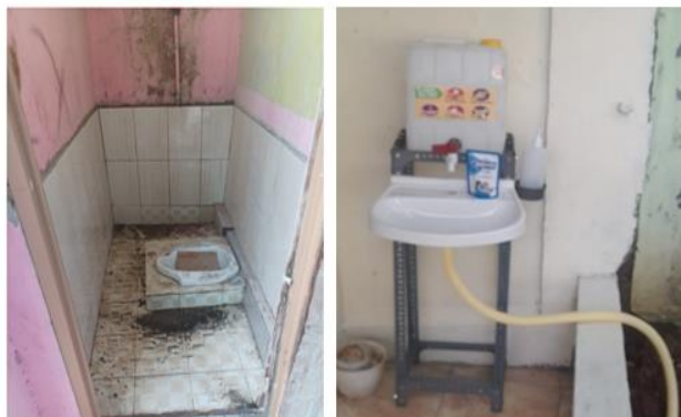
Gambar 3 Renovasi atau Perbaikan Toilet dan Penyediaan Washtafel Fortable
