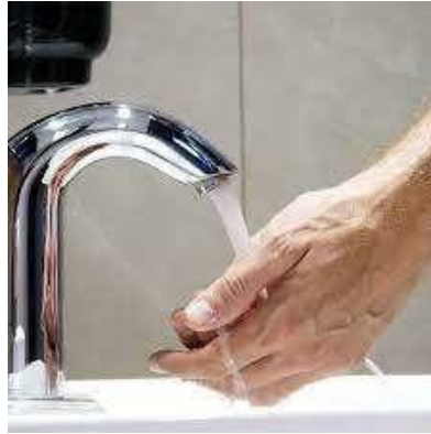
Gambar 2. Sensor berada pada pangkal kran (Selma, 2022)
