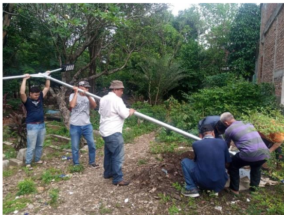
Gambar 4. Proses instalasi 2-titik tiang penerangan berbasis PLTS di area makam Pangeran Surya
