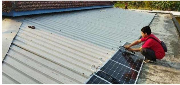
Gambar 11. Pemasangan Panel Surya
