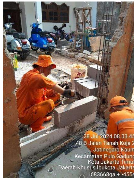
Gambar 8 Pekerjaan perbaikan pagar
