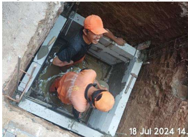
Gambar 5 Pemasangan dinding hebel
