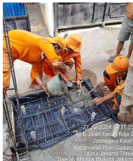
Gambar 7 Pekerjaan pemasangan besi dan pengecoran tutup lubang corong drainase vertikal
