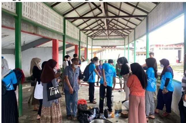
Gambar 3. Demonstrasi dan Proses Pembuatan Paving Blok
