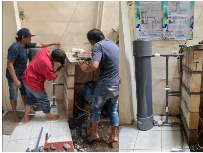
Gambar 4. Teknologi tepat guna instalasi filterisasi air berlapis yang diterapkan di sekolah SMPIT As Salam. a. Pemasangan instalasi filterisasi air berlapis. b. Instalasi filterisasi air berlapis yang siap beroperasi
