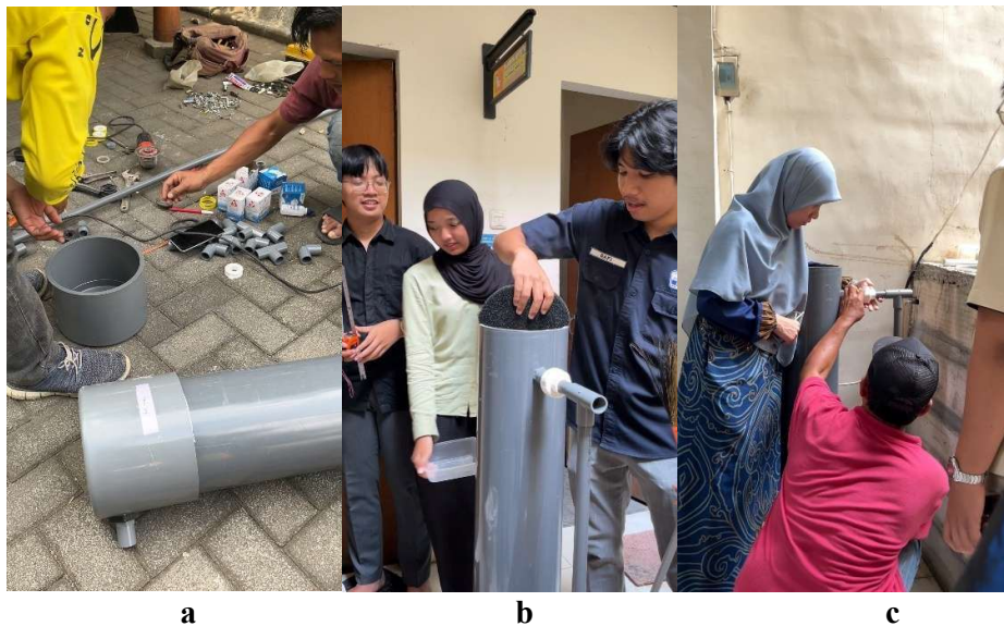
Gambar 2. Kegiatan pembuatan filter air berlapis di SMIT As Salam. a. Perakitan instalasi filterisasi air berlapis. b. Pengisian media penyaring di dalam paralon. c. Pemasangan instalasi filterisasi air berlapis pada instalasi sumur air sekolah
